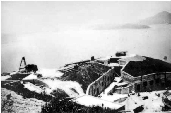
約 1911 年快將竣工的摩星嶺炮台。
